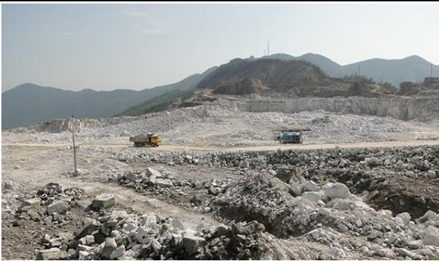
图 15：“宜春钽铌矿”（原四一四矿）旗下的采矿区域现场
