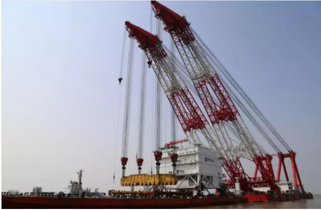
图 34：响水海上风电项目升压站吊装
